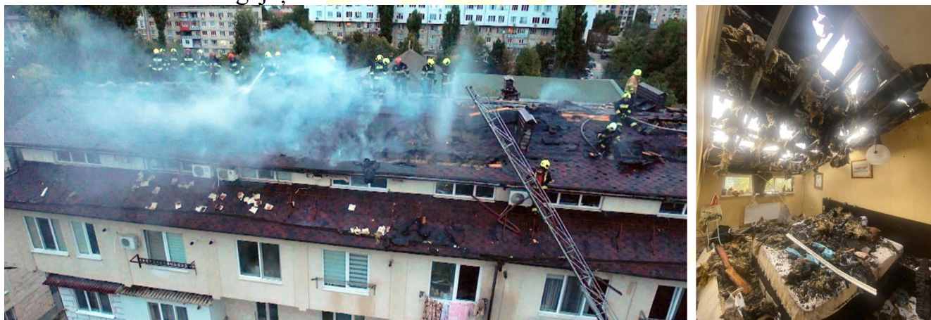
Figura 33 - Lichidare a incendiului produs la nivelul 6 (mansardă) de pe strada Paris 34/2, mun. Chișinău
