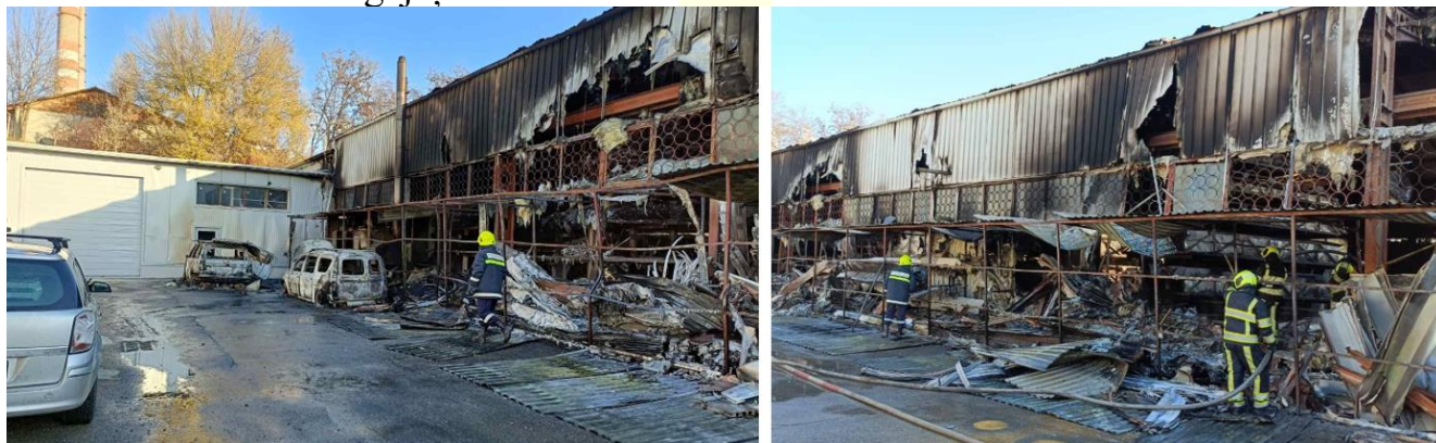
Figura 34 - Acțiuni de lichidare a incendiului produs în depozitul SRL „Cvandit”
